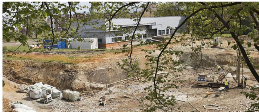
Las obras de la nueva sede del IFLA junto a las instalaciones del INCAR en La Corredoria. | Miki López
